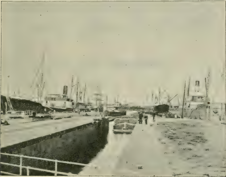
ÉCLUSES DU BASSIN DE BATELLERIE.
